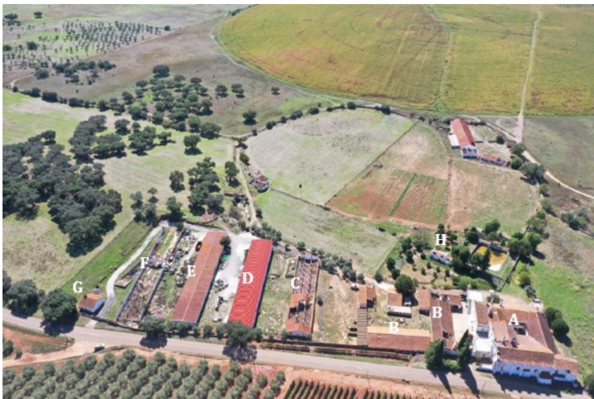
Figura 3 - Identificação do edificado pré-existente na área de intervenção, alvo de recuperação e/ou reabilitação (fonte: HM.arch)
